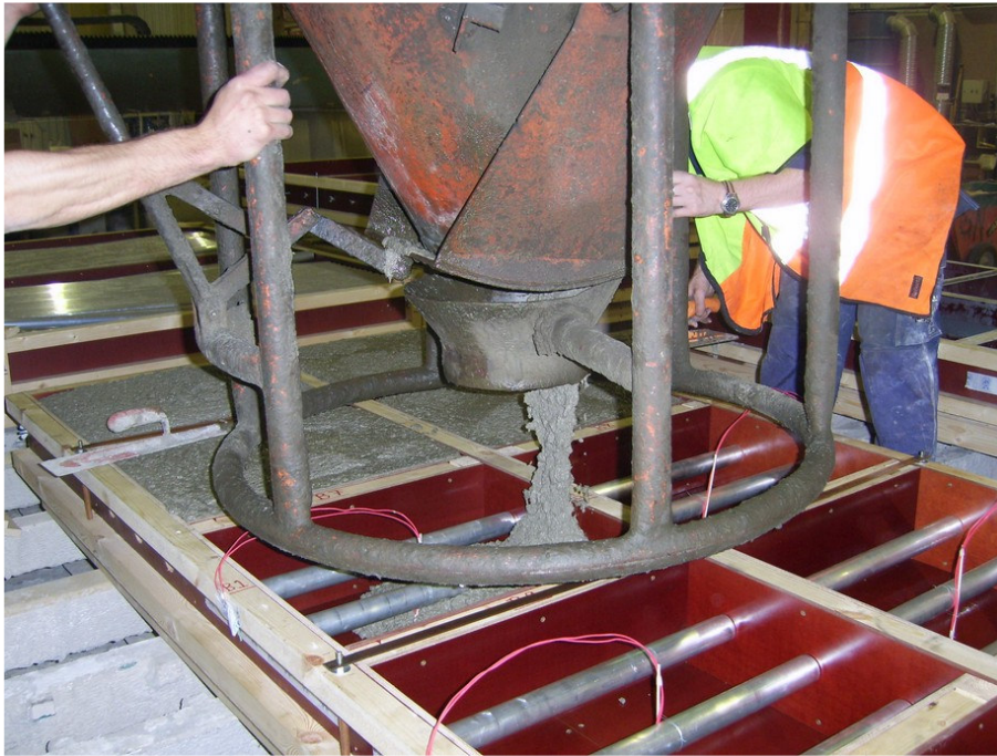
Figur 4-6 Gjutning av element
