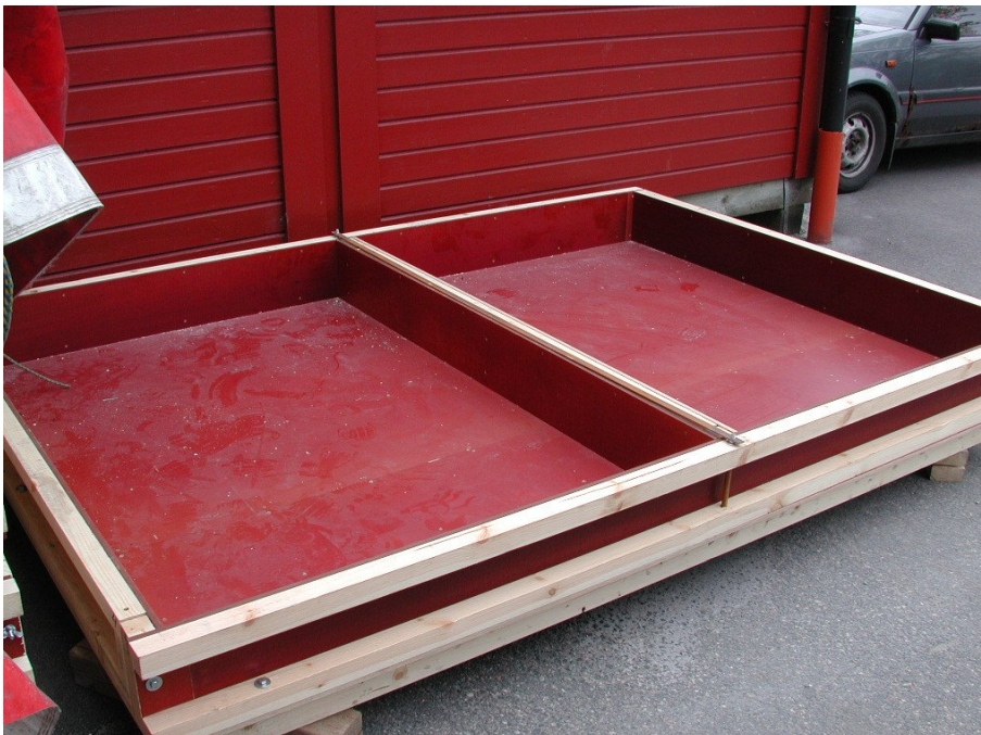
Figur 4-3 Stor form för gjutning av stora element
